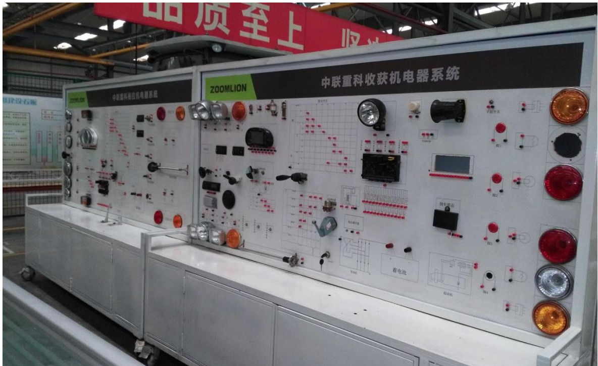
图8 中联重科开封工业园技能培训中心实训台
